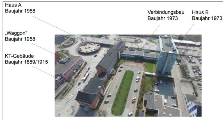
Abb. 3: Luftbild mit Gebäudebestand
