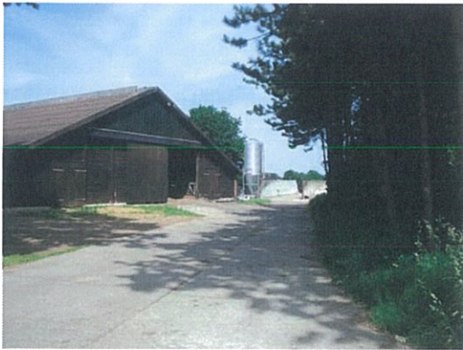
Abb. 12: Betriebsgebäude nördl. Geltungsbereich
