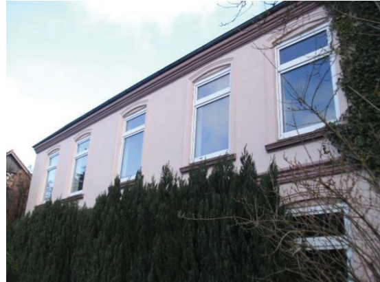
Abb. 3: Fassade von vorne
