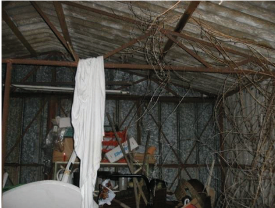
Abb. 2: Schuppen / Garage von Norden
