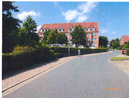
Foto 2: Blickrichtung Westen auf die Mehrfamilienhausbauung südlich der Elsa-Brandström-Straße
