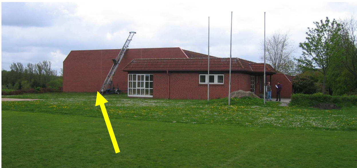
Abbildung 2: Standort des Anbaus an der Sporthalle
