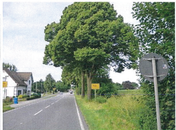
Abb. 9d Blick in entgegengesetzter Richtung auf den Ortseingang mit den Bäumen der „Halballee“ und dem Knick
