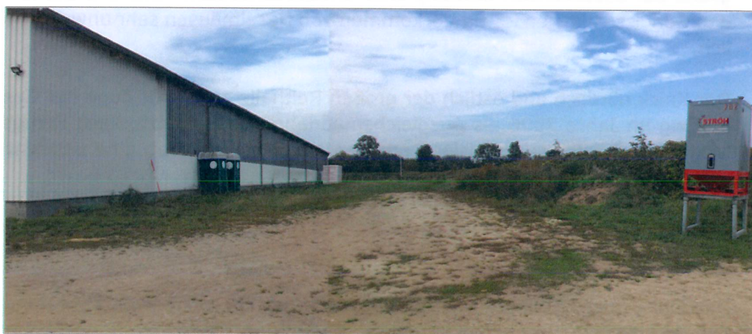
Abb. 4: Vorhabenfläche mit bestehender Reithalle und Knickwall
