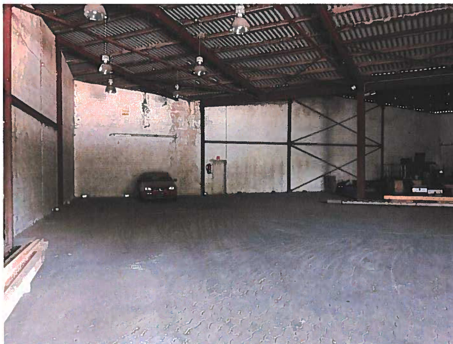
Foto 4: Blick nach E in Lagerhalle an nördlicher Grundstücksgrenze
