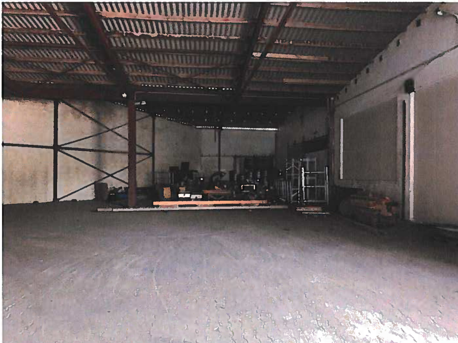
Foto 5: Blick nach E in Lagerhalle an nördlicher Grundstücksgrenze
