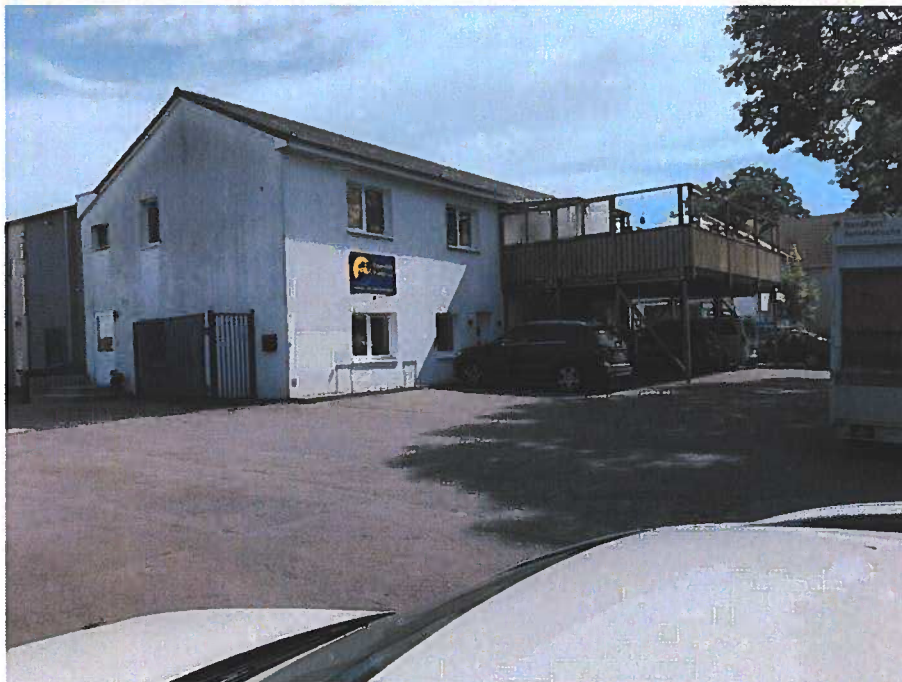
Foto 13: Blick nach NE auf Bürotrakt
