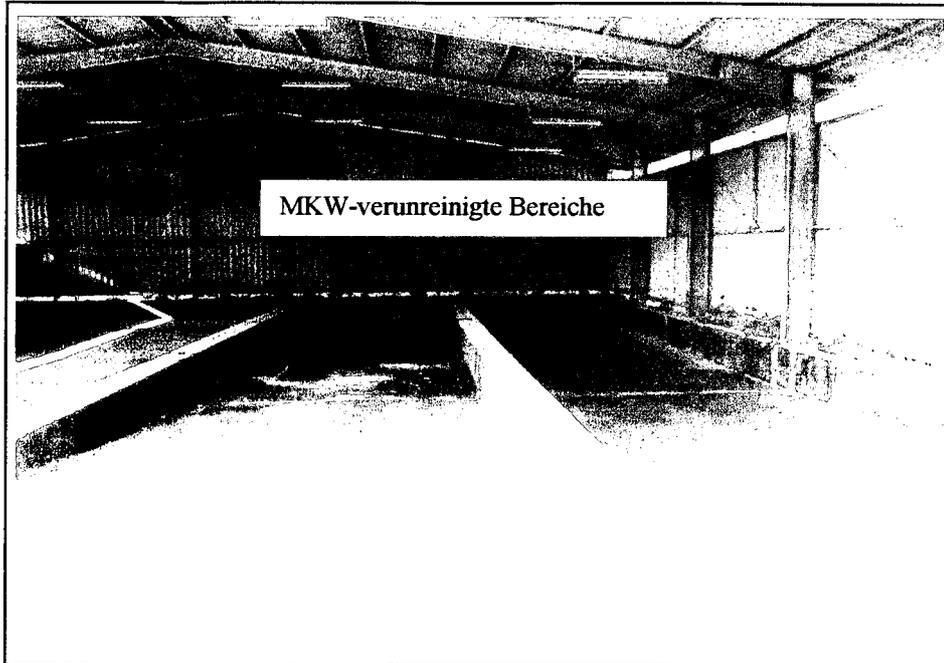
**Bild 5: Kraftstofflagerhaus (8) mit Verunreinigungen auf der Oberfläche (dunkel gefärbte Bereiche)**
