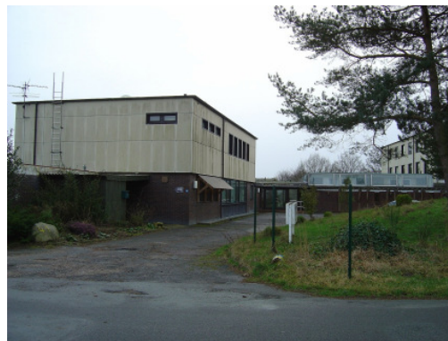
Blick von der Strasse auf das Planungsgebiet
