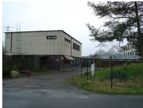
Blick von der Strasse auf das Planungsgebiet
