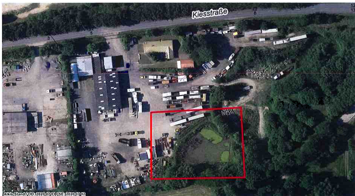
Löschwasser- und Regenwassersammelteich
