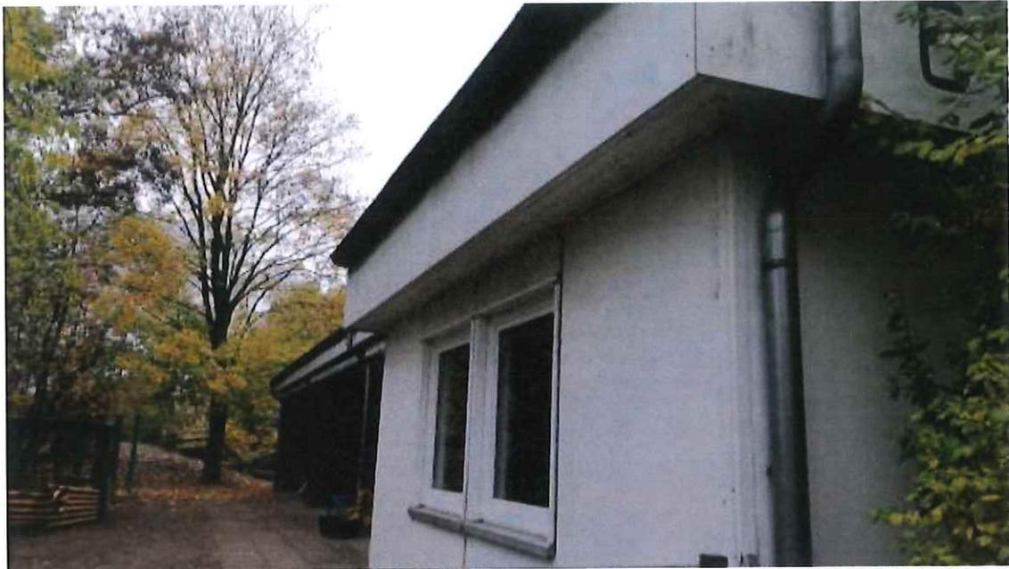
Dachunterstand als Verschalung, Dach in Metallprofilen gedeckt
