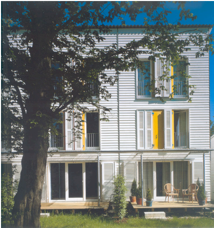
Reihenhaus mit Niedrigenergiestandard in Göppingen, Architekten Wick + Partner, Stuttgart 5
