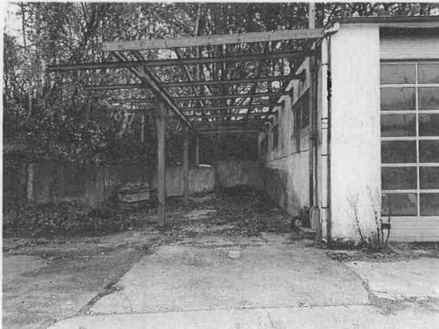
Foto 4 Ehemaliger Standort oberirdischer Dieseltankanlage
