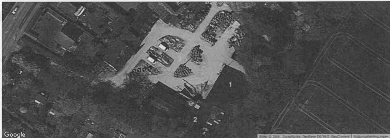
Abbildung 1: Übersicht über das ehemalige Betonwerk sowie Lage der stationären Erfassungen; A = Verwaltungsgebäude, B = Hallen.
