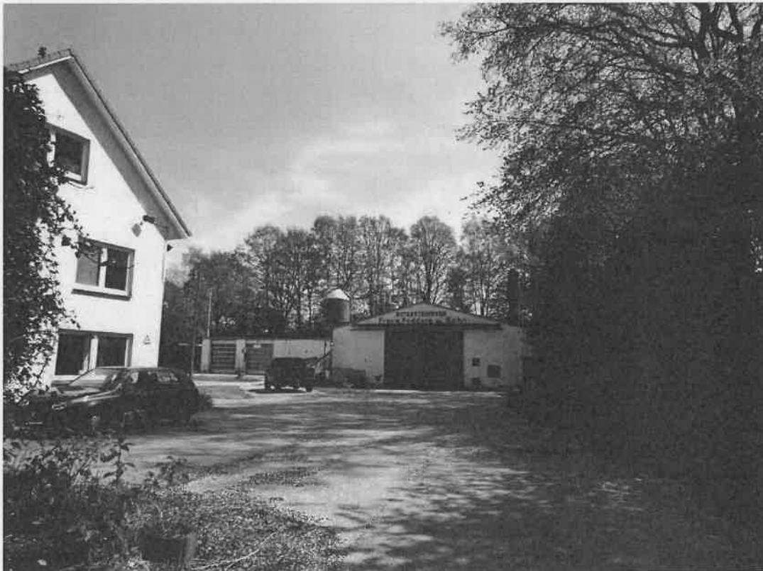
Abb. 3: Bestandgebäude auf dem Gelände des ehemaligen Betonsteinwerks Feddern; Die Außenmauern des Bestandgebäudes dienen als Befestigung für den Wall
