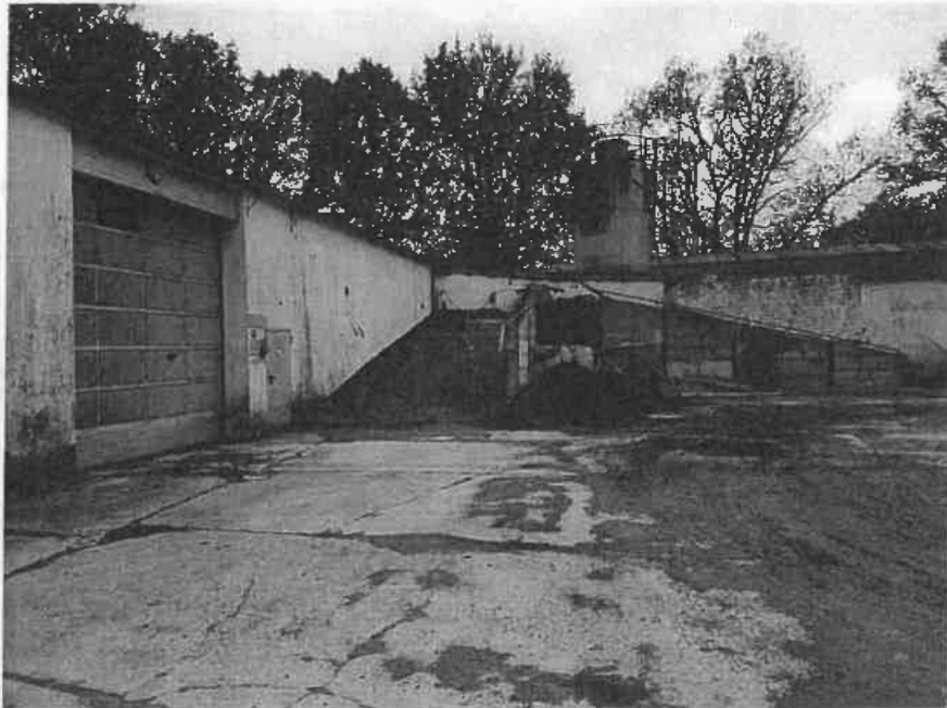
Foto 5 Werkstatthalle / Lager für Zuschlagstoffe
