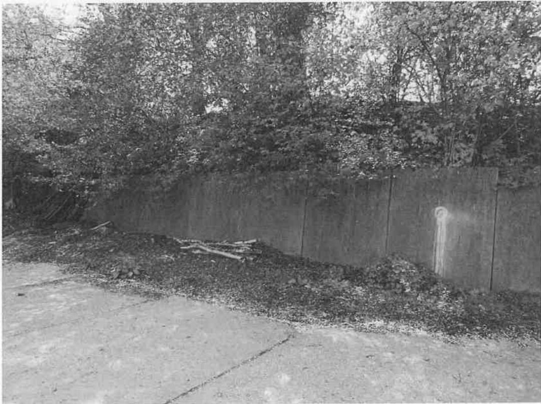
Abb. 2: Strauchbewuchs und Jungbäume auf dem Wall; Betonsteinelemente zur Befestigung des Walls im vorderen Bereich der südwestlichen Grundstücksgrenze
