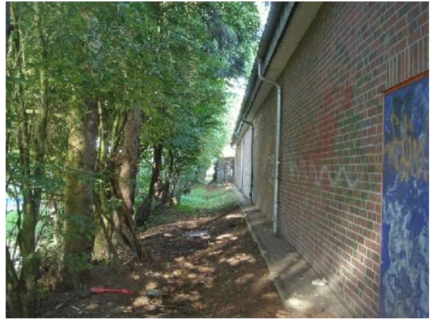
Abb. 3h entlang der Gebäuderückseite ist eine lineare Entwässerungsmulde vorhanden
