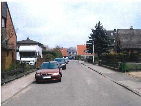
Abb. 7 Ausbauzustand der Straße „Nelkenweg“ mit Blick nach Norden zur „Lohe“
