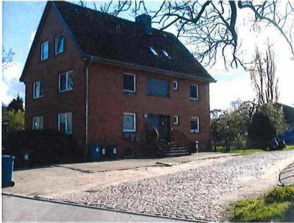
Abb. 13 Zufahrtbereich „Am Bornberg“ mit Blick auf das Mietshaus Nr. 4
