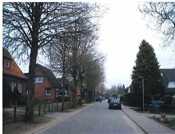
Abb. 6 Auszustand der Straße „Am Bornberg“ mit beidseitiger Wohnbebauung
