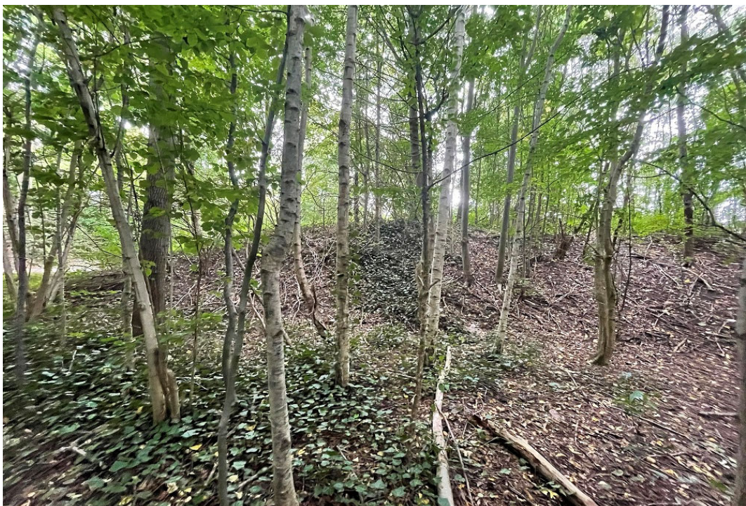
Abb. 5: Wall mit Gehölzaufwuchs
