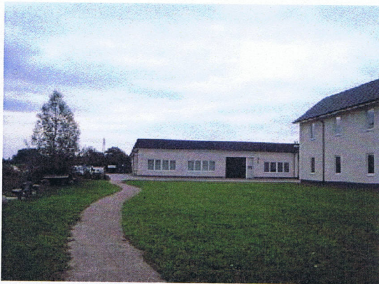
Abb. 8 Blick vom nordwestlichen Plangebietsrand im Bereich der „Sickermulde“ auf das heutige Betriebsgebäude C - Verpackung (P. Scharlibbe 13.07.2011)
