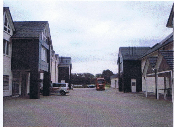
Abb. 7 innerbetriebliche Erschließungsstraße mit dem Betriebsgebäude C (Verpackung) hinten am rechten Bildrand (P. Scharlibbe 13.07.2011)
