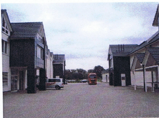
Abb. 17 innerbetriebliche Erschließungsstraße mit der beidseitigen markanten Baustruktur mit Blick nach Norden zum Plangebiet und dem geplanten Erweiterungsbau in Höhe des roten Lkw's (P. Scharlibbe 13.07.2011)
