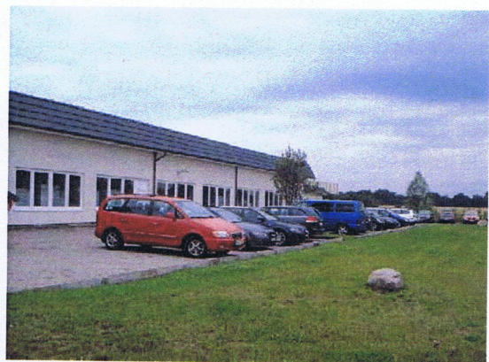
Abb. 9 Blick von der derzeit unbebauten Fläche, die für die Erweiterungsbaumaßnahme genutzt werden soll, auf die nördliche Gebäudeseite der Verpackungshalle (P. Scharlibbe 13.07.2011)
