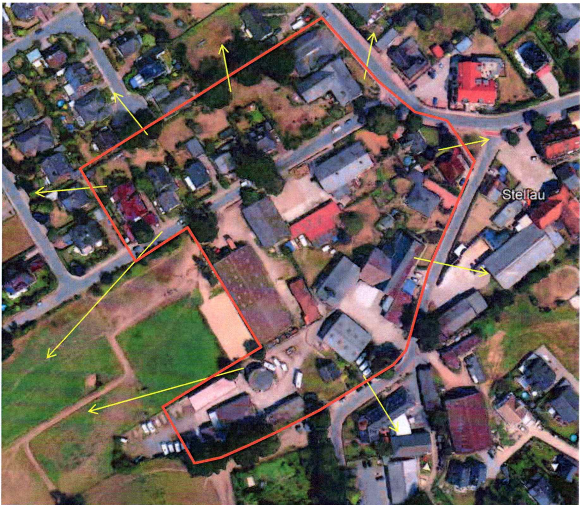
Abb. 3: Geltungsbereich (rot) und Wirkraum der zu erwartenden Wirkfaktoren in gelb (s.a. Abb. 2)
