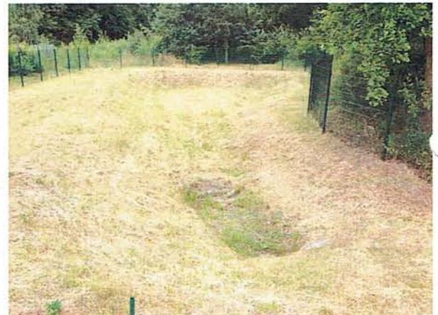
**Abb. 8** Regenversickerungsbecken nördlich des Parkplatzes mit Zulauf von dort in der Zuständigkeit des ZV Südstormarn
