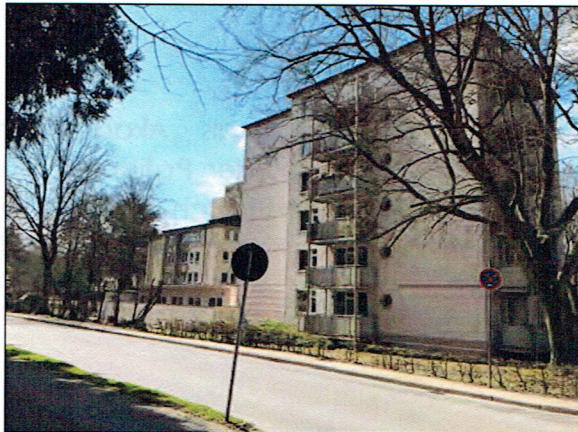
Abbildung 6: Vorhandene vier- bzw. sechsgeschossige Baukörper im Nordosten am Wöhrendamm
