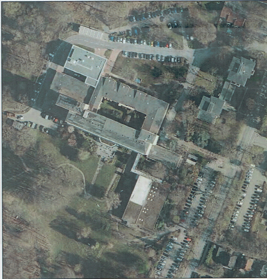
Abbildung 8: Luftbild des Geländes der LungenClinic am Wöhrendamm
