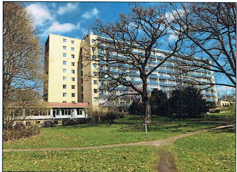
Abbildung 3: Das zukünftig entfallende Bettenhaus von Süden
