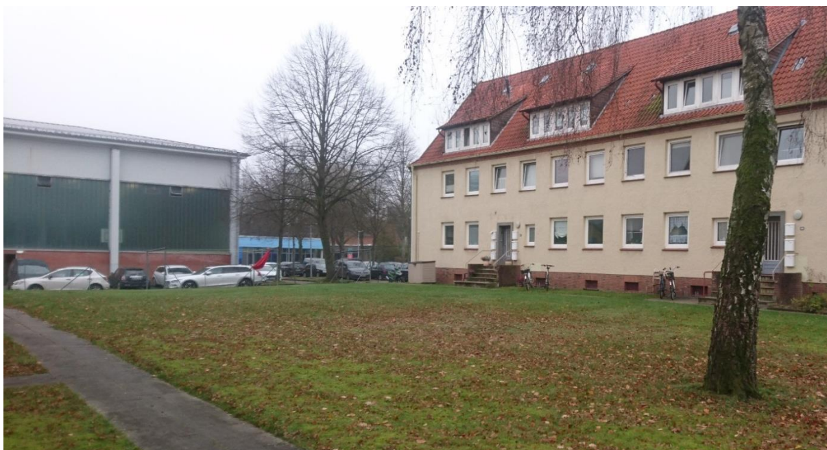
Abbildung 8: Durch die fehlende Trennung zum dahinterliegenden Schulgelände sinkt die Aufenthaltsqualität
