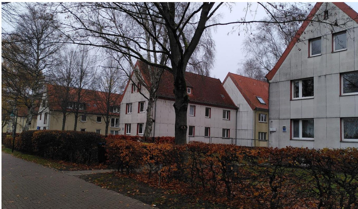
Abbildung 5: Blick von der Sieker Landstraße auf das Plangebiet
