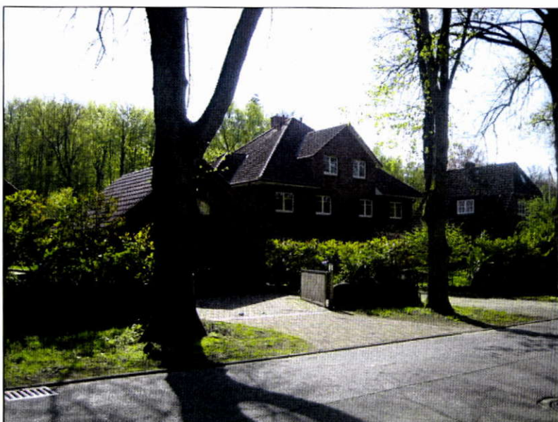
Vorhandene Doppelhausbe- bauung Hoisdorfer Land- straße Nr. 121/123
