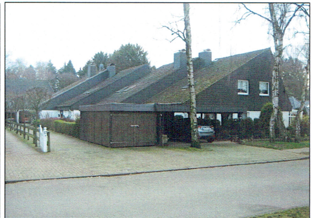
Abbildung 6: Reihenhausbauung Himmelshorst 17c, 17d 17e und 17f
