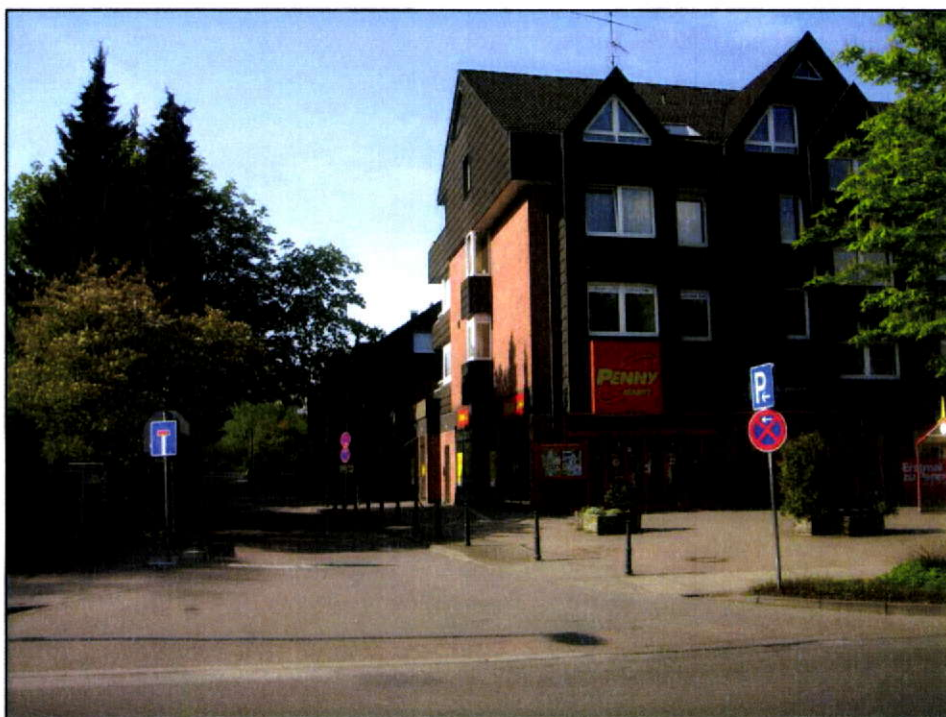
Bild 1: Vorhandene Bebauung am Eilbergweg / Ecke Neuer Postweg
