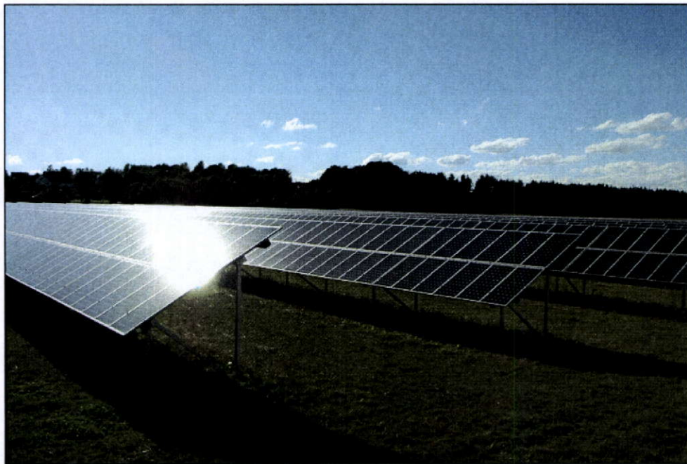
Abbildung 1: Beispiel einer Freiflächen-Solaranlage; erkennbar Schattenbildung sowie geringfügige Versiegelung (Quelle: Baltic Solar)
