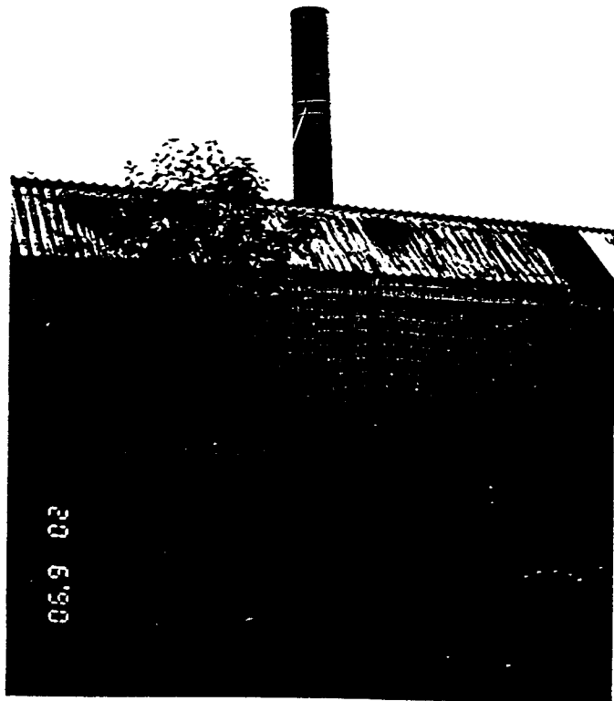
Bild 12: Die Abluft aus dem Endmaststall des Betriebes AHLERS, Kamp 16, wird ca.3,5m über First abgeführt
