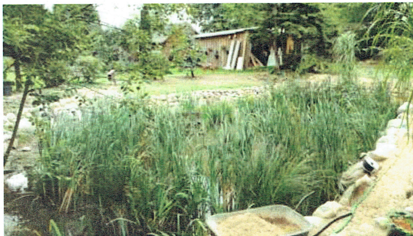
Foto 3: Regenrückhaltebecken, naturnah gestaltet mit Rohrkolben, Seggen, Stauden
