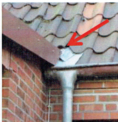
Foto 3: Wohnhaus Alte Landstraße Nr. 36, Rückseite mit Beispiel für kleine Spalten (s. Pfeil)
