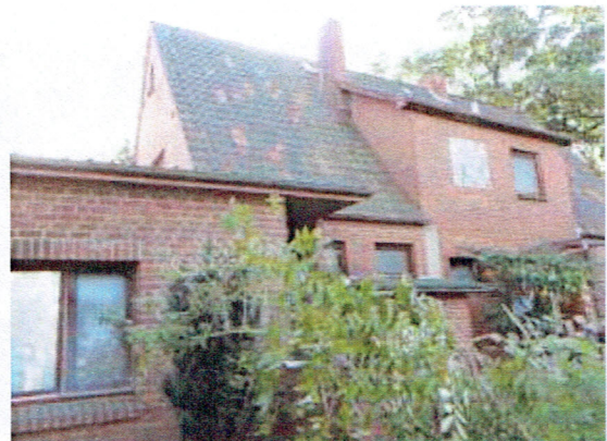
Foto 2: Wohnhaus Alte Landstraße Nr. 36, Rückseite
