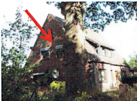
Foto 1: Wohnhaus Alte Landstraße Nr. 36, Vorderseite, Nordwestseite mit Jalousienkästen (s. Pfeil)
