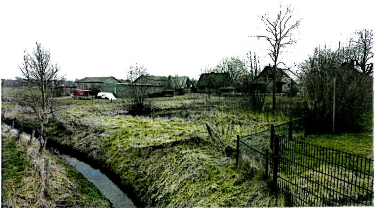
Abbildung 12: Regenrückhaltbecken/Feuerlöschteich mit Ruderalfluren
