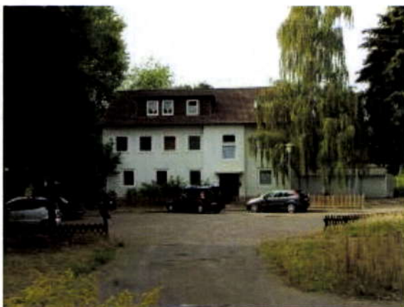
Abb. 20 Der Wendeplatz wird immer wieder durch private Pkw's der angrenzenden Wohnbebauung stark eingeschränkt; teilweise bis in den Knickschutzstreifen hinein (P. Scharlibbe 19.09.2009)
