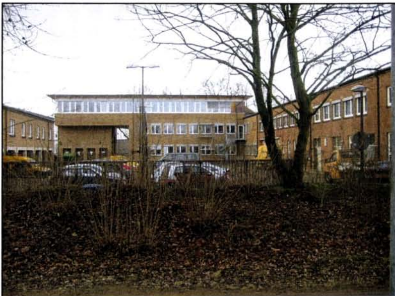
Abbildung 6 Betriebsgebäude mit neuem Erweiterungsbau
