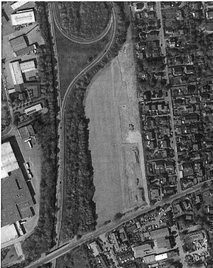
Abb. 1 Räumliche Lage des Planbereiches der 1. ver. Änderung des Bebauungsplanes Nr. 98 im Stadtteil Neuschönningstedt östlich der K 80 und nördlich „Oher Weg“ zu Beginn der Erschließungsarbeiten des Wohngebietes „Schröders Koppel“
