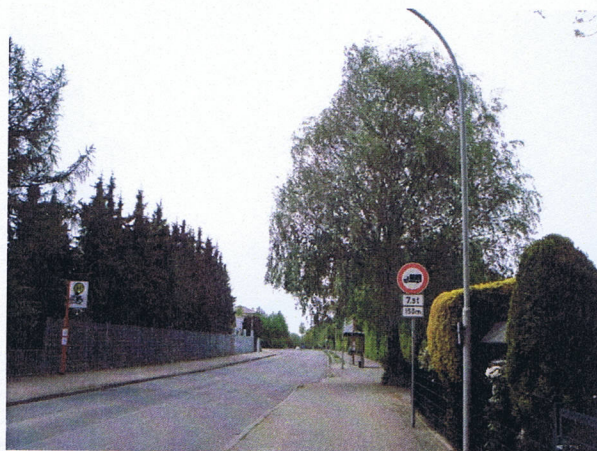
Abb. 8 Blick von Osten in Richtung Glinde / Brücke K 80 mit dem „Oher Weg“ als äußere Plangebieterschließungsstraße
