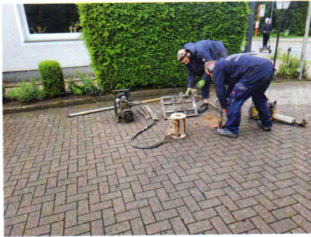
Foto 1: Sondierarbeiten an KRB 3
