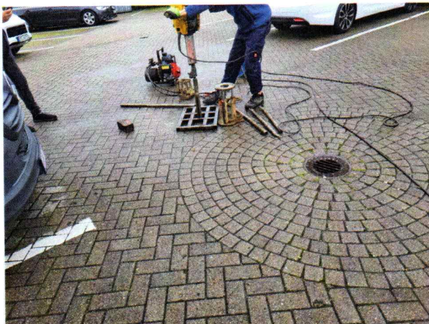
Foto 3: Sondierarbeiten an KRB 1
