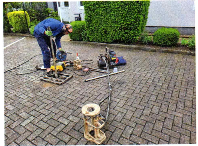
Foto 2: Sondierarbeiten an KRB 2
