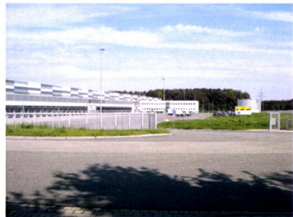
Abb. 4 Ostseite des Zentralwarenlagers mit den Lkw - Andockplätzen und angrenzenden Stellplatzflächen mit Blick nach Norden (P. Scharlibbe vom 23.08.2011)
