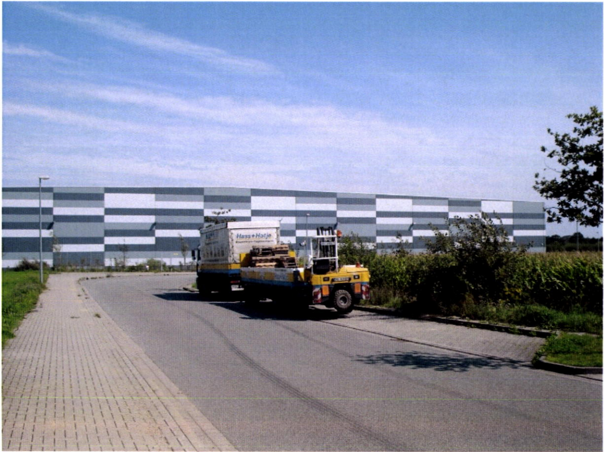
Blick auf die südliche Gebäudefront des „Zentralwarenlagers“ an der Straße Jacobsrade im Gewerbegebiet Siek - Jacobsrade“ der Gemeinde Siek
