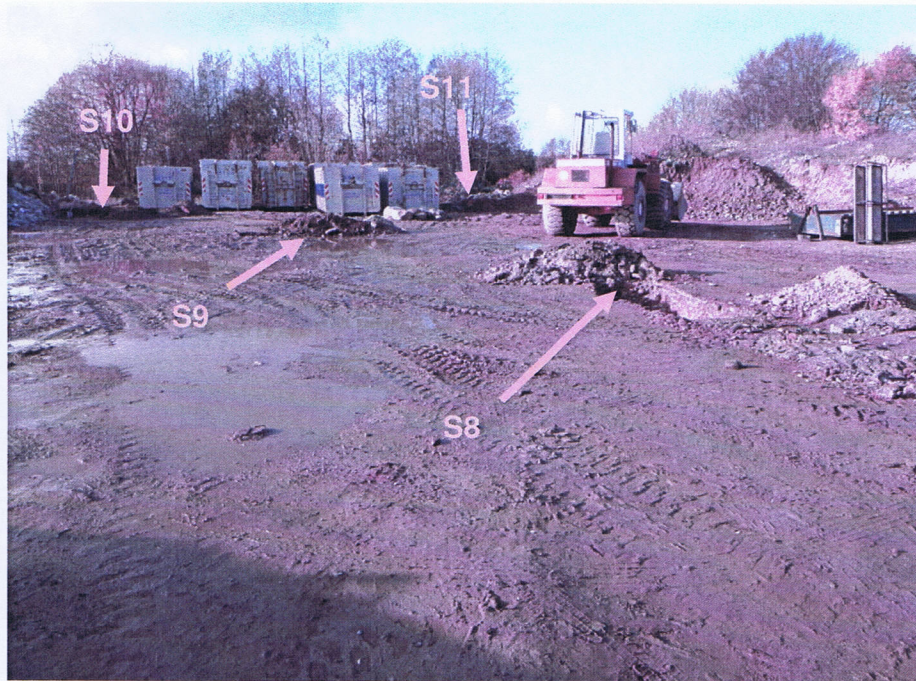
Foto 9: Blick nach Westen auf die Baggerschürfe S8, S9, S10 und S11 (s. Pfeile), die im Bereich der ehemaligen Lagerfläche von Halde IV ausgeführt wurden.
