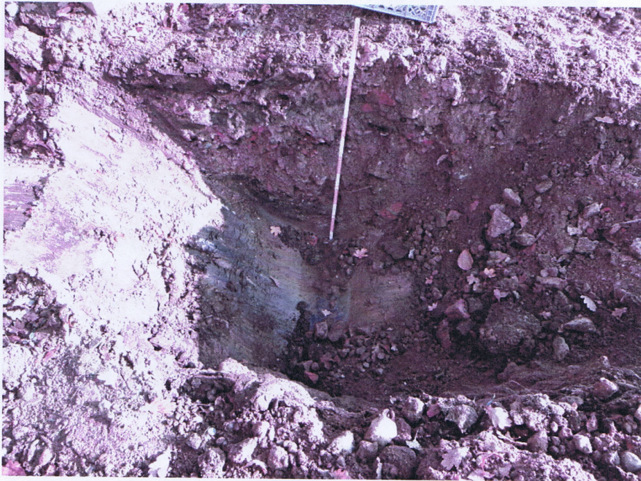
Foto 7: Baggerschurf S6 (ehemalige Lagerfläche von Halde III).
