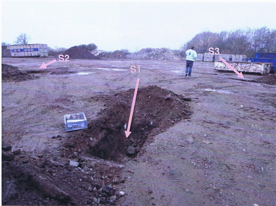
Foto 1: Blick nach Westsüdwesten über die beprobte Fläche des Grundstücks Hauptstraße 64 und die Baggerschürfe S1, S2 und S3 (s. Pfeile), die im Bereich der ehemaligen Lagefläche von Halde H II (gemäß Dekra-Gutachten vom 18.10.2012) ausgeführt wurden.
