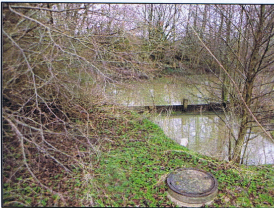
Foto 11: Regenrückhaltebecken im Nordwesten
